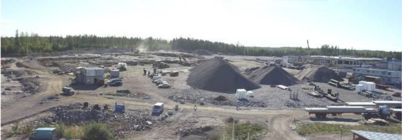
Utsikt från räddningsstationens slangtorn mot planområdet 21.9.2006.
