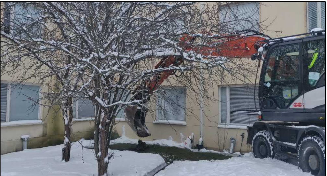
Kuva 2. Tutkimuspisteet FCG1 ja FCG3 tehtiin rakennuksen kulman läheisyyteen, kuvan vasempaan reunaan ja tutkimuspiste FCG2, öljysäiliön täyttöputken läheisyyteen, kuvassa kaivurin etupuolelle. Maakerrokset öljysäiliön kohdalla ovat hienoa hiekkaa ja silttiä, jonka alapuolella tulee vastaan pohjamaa savi.
