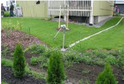
Bild 6. Vatten från ytan har letts i en underjordisk tank via betongrör och från taket via ett regnvattenrör och underjordiskt trumrör. Man kan använda vattnet från regnvattentanken genom att pumpa upp det med en handpump.
