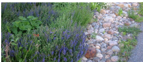
Bild 16. Infiltreringsområdets yta vid kanten av gårdsgången och parkeringsplatsen består av kullerstenar och en perennplantering. Infiltreringen vattnar planteringarna.
