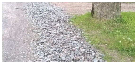
Bild 17. Ytan för infiltreringsremsan vid kanten av körrutten består av kross. Infiltreringen vattnar gräset och trädet.
