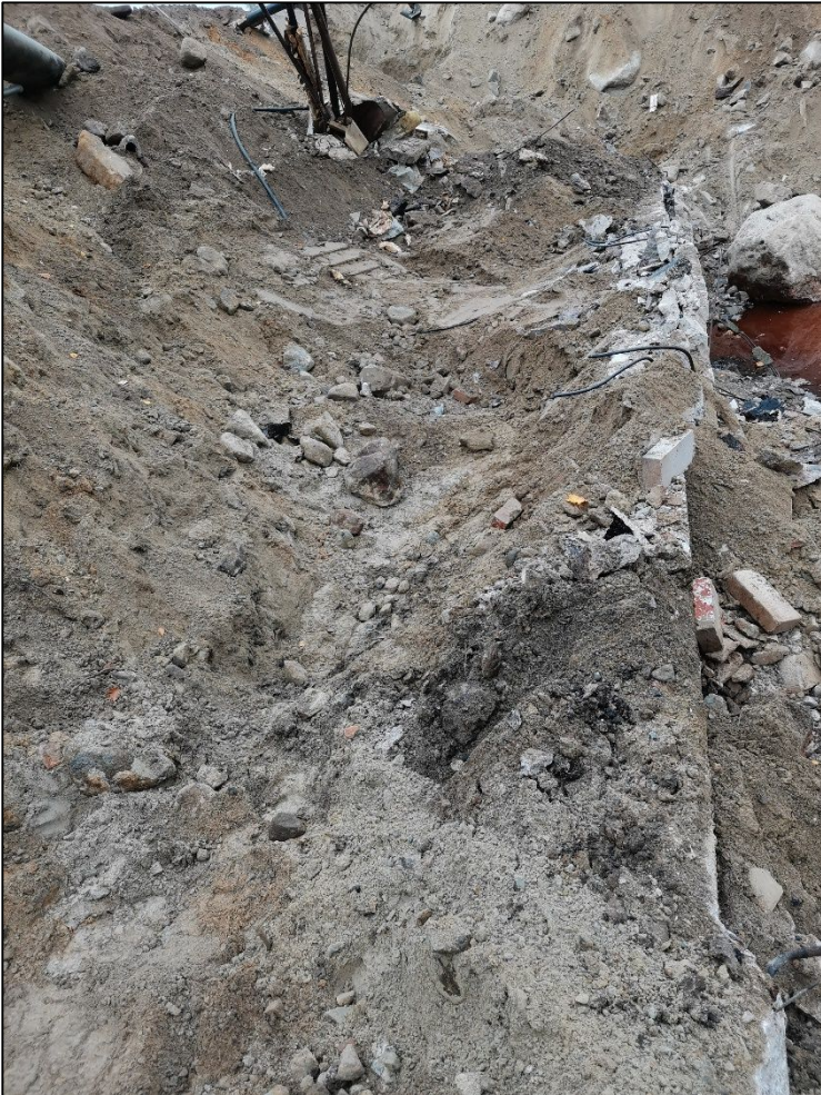
Kuva 5. Kaivannon pohja. Kaivu päättyi kallioon. Rakennuksen sokkeli oli purkamatta.
