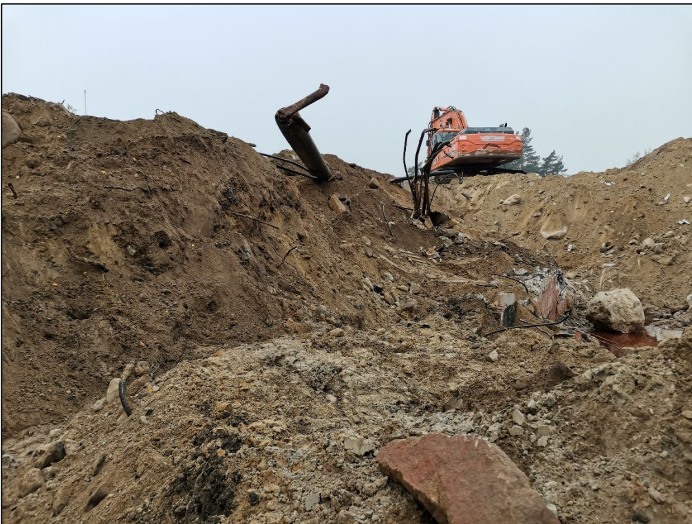
Kuva 2. Öljysäiliökaivannon vastainen seinämä.
