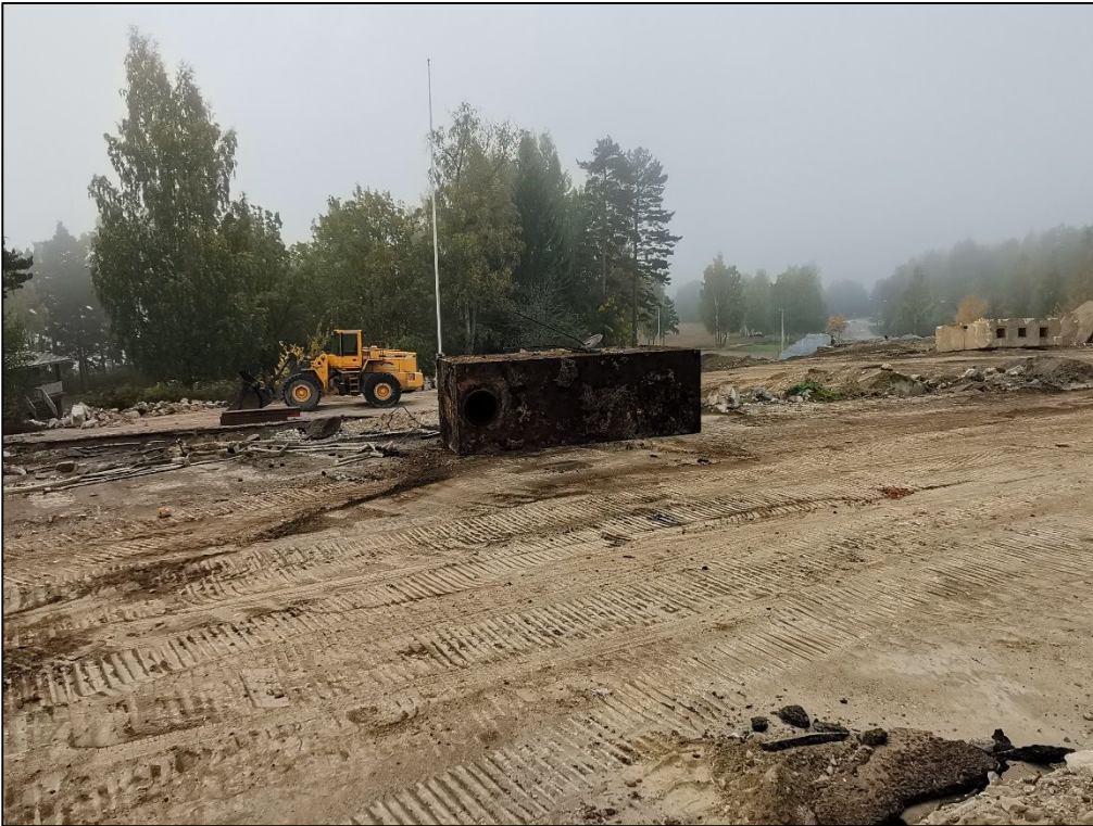
Kuva 1. Kaivannosta poistettu vanha öljysäiliö.
