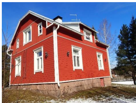
Bild 6 Verandan har byggts ut för våtrum.
