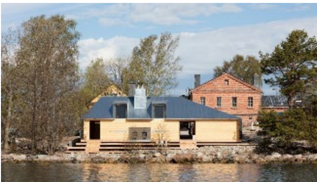
Bild 16. Terrass- och bryggkonstruktionerna ska byggas i nivåer så att separata räcken inte behövs mot stranden (bilder: Lonna sauna/OOPEAA och Saunaravintola Kiulu/Studio Puisto).
