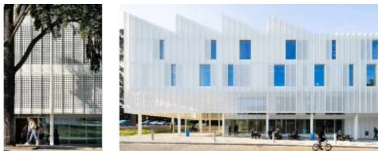
Bild 4. Principen med perforerad skiva, där fogarna har böjts utåt, skapar skuggor och djup i fasaden (Digi-Tech Factory/Coffey Architects).
