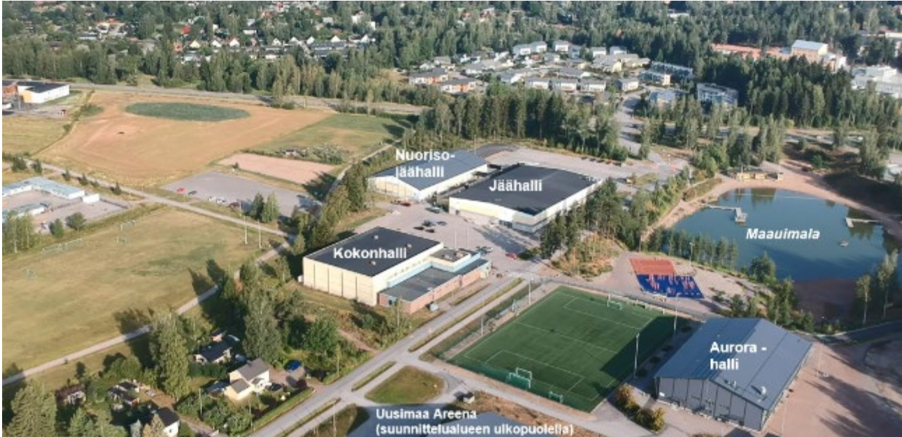
Kuva 4. Alueen rakennuskanta ilmakuvasa selittävin tekstein. Ilmakuva, ote videosta 8.8.2019.
