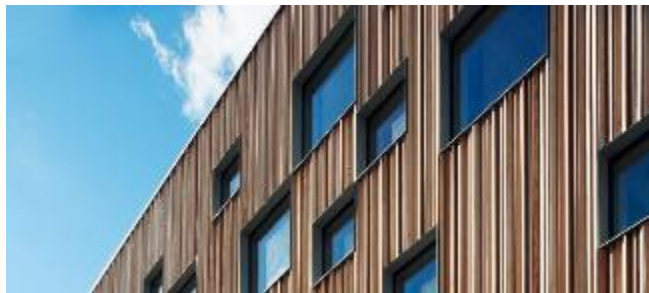
Kuva 7. Vaihtelevan syvyinen puujulkisivu luo syvyyssvaihtelua ja pehmentää julkisivua (Umeå School Of Architecture / Henning Larsen Architects).
