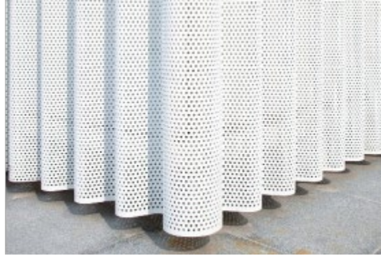
Kuva 6. Perforoitu alumiinilevy, jossa on sekä läpikuultavia että umpiosia. Aaltoileva pelti luo syvyyssvaihtelua sekä pehmentää rakennusta (Schmidt Hammer Lassen, Shanghai office block).
