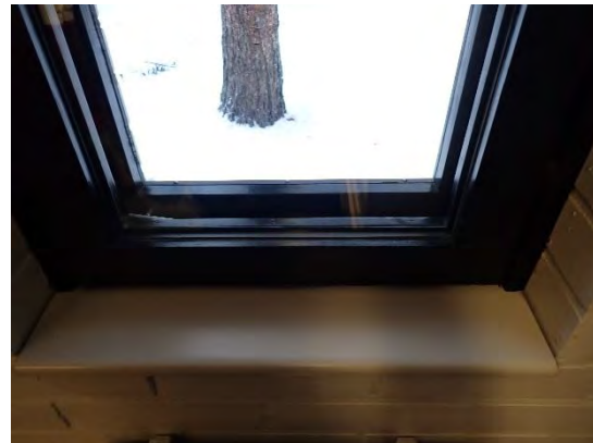
Kuva 35. Rakennuksen ikkunat olivat MSE-ikkunoita, sisäpuitteessa havaittiin eristyslasi.
