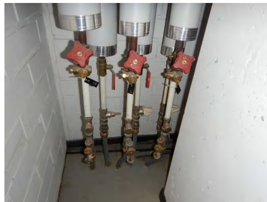
Kuva 75. Lattialämmityspiirien säätöventtiilit.
