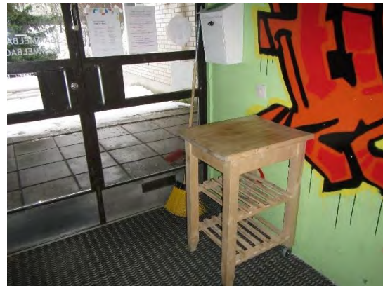
Kuva 39. Myös tuulikaappiin 1036 johtava ovi oli alkuperäinen ikkunallinen ja metallirakenteinen ulko-ovi.
