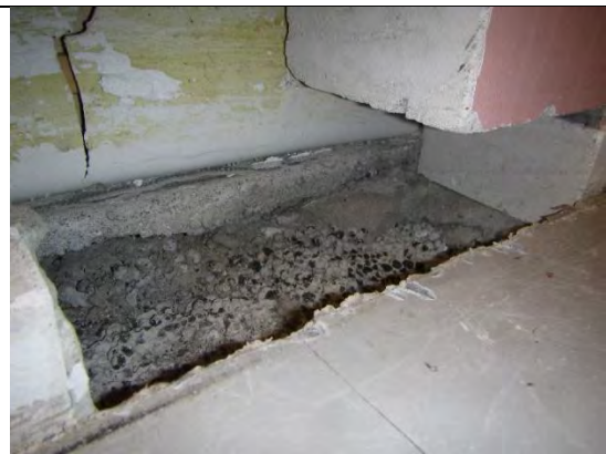
Kuva 58. Tiilirakenteiset väliseinät alkavat kevytbetoniharkon päältä.
