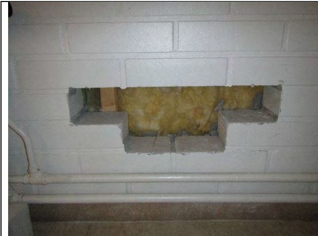
Kuva 33. Valokuva rakenneavauksesta.
