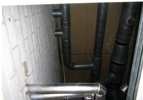
Kuva 49. Alaslaskettujen kattojen päällä kulki ilmastointikanavia ja vesiputkia.
