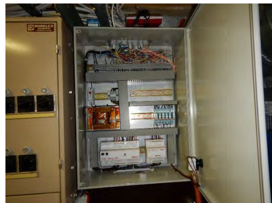
Kuva 91. Ilmanvaihdon automaatiokeskus.
