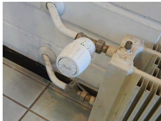
Kuva 77. Uusittu patteritermostaatti.
