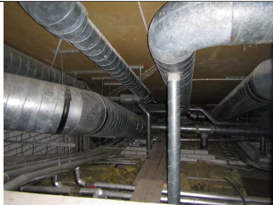
Kuva 53. Puku, pesu- ja saunatilojen alakattojen yläpuoleinen tila.
