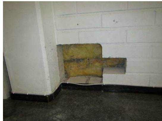
Kuva 28. Ulkoseinien sisäpinnat olivat pääosin tiiliverhoituja, kuvassa rakenneavaus RA13. aulatilassa 1052.
