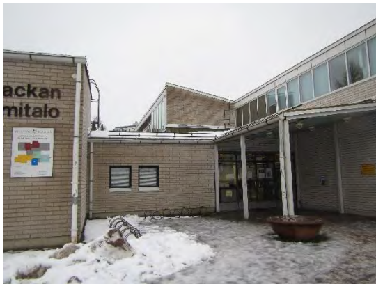
Kuva 38. Rakennuksen pääovi oli alkuperäinen ikkunallinen ja metallirakenteinen ulko-ovi.
