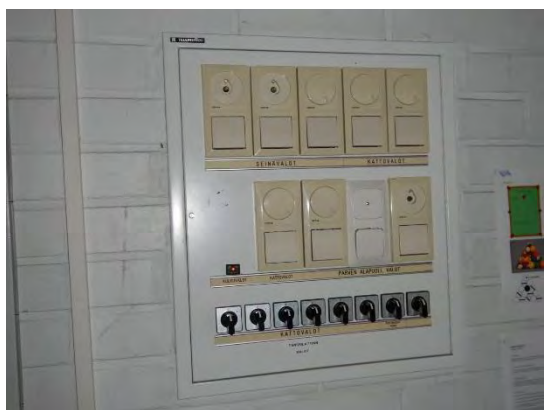
Kuva 86. Alkuperäinen valaistuksen ohjauskeskus.
