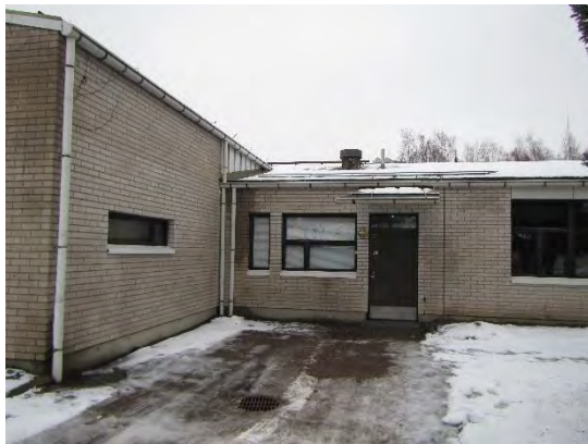
Kuva 27. Rakennuksen ulkoseinät olivat tiiliverhoituja ulkoseinärakenteita.
