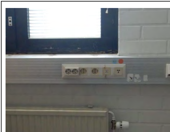
Kuva 88. Johtokouruun asennetut alkuperäiset pistorasiat ja puhelinpistorasiat.
