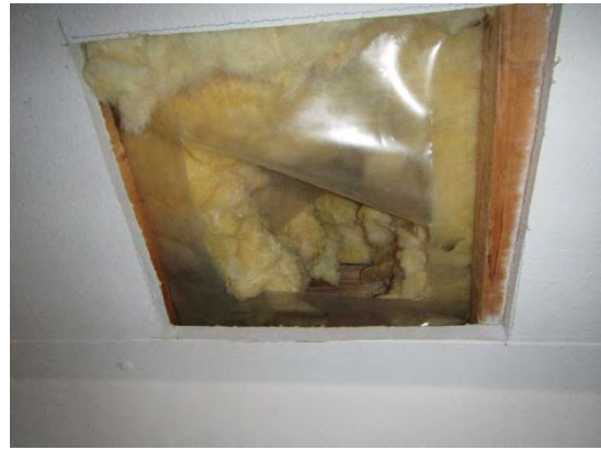
Kuva 71. Tilan 1001 yläpohjan rakenneavaus RA7.
