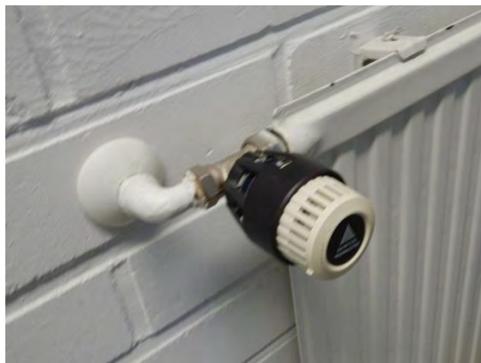
Kuva 76. Alkuperäinen patteritermostaatti.
