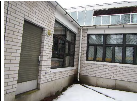
Kuva 40. Pienemmät ulko-ovet olivat metallirakenteisia.
