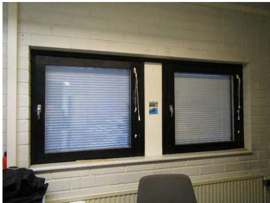
Kuva 34. Rakennuksen ikkunat olivat pääosin kaksilasisia ja puurakenteisia.
