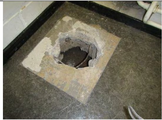
Kuva 5. Rakenneavauskohta RA3 alapohjarakenteeseen AP1 kirjaston tilassa 1093.
