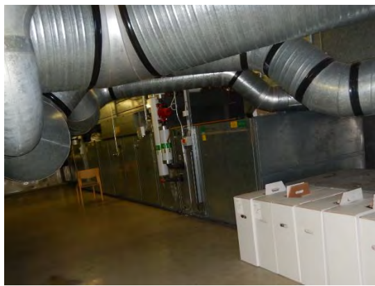
Kuva 82. Alkuperäinen ilmanvaihtokone.
