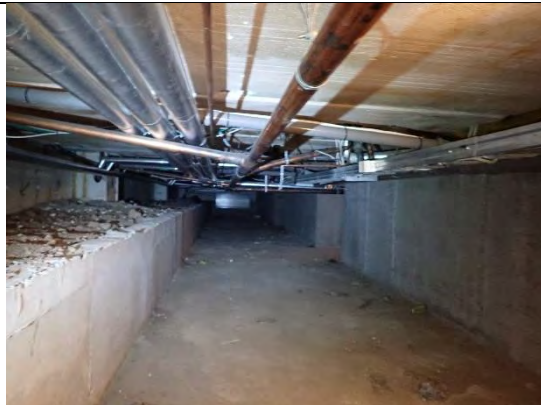
Kuva 14. Alapohjatilassa oli erillinen rajattu tekniikkatila. Tilan lattia oli osin betoni- ja osin maapintainen
