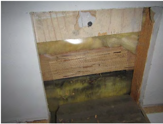
Kuva 70. Tilan 1094 yläpohjan rakenneavaus RA5.
