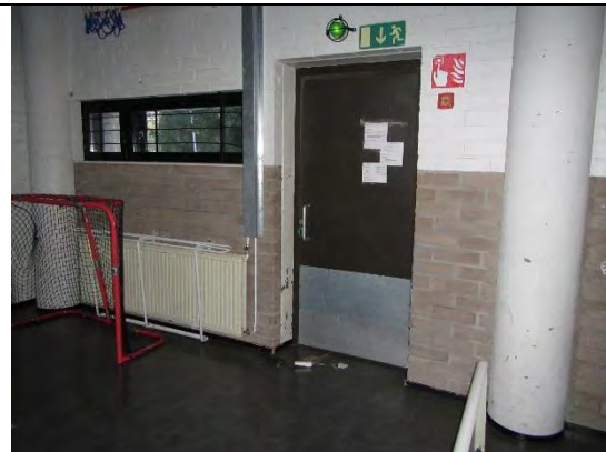
Kuva 41. Salin 1038 ulko-ovesta veti ja oven edusta oli erittäin kylmä.
