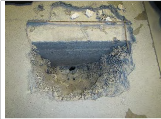
Kuva 4. Rakenneavauskohta RA8 alapohjan rakennetyyppien AP1 ja AP2 rajapintaan tilassa 1024.
