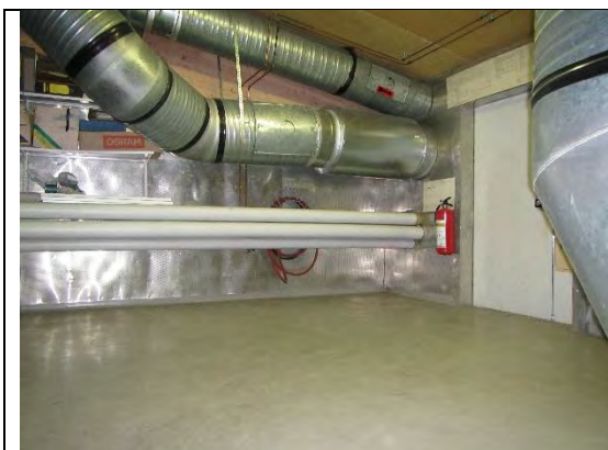
Kuva 45. IV-konehuoneen 2001 välipohja oli ontelolaattarakenteinen.
