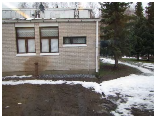
Kuva 24. Alustatilan tuuletuspaalu.
