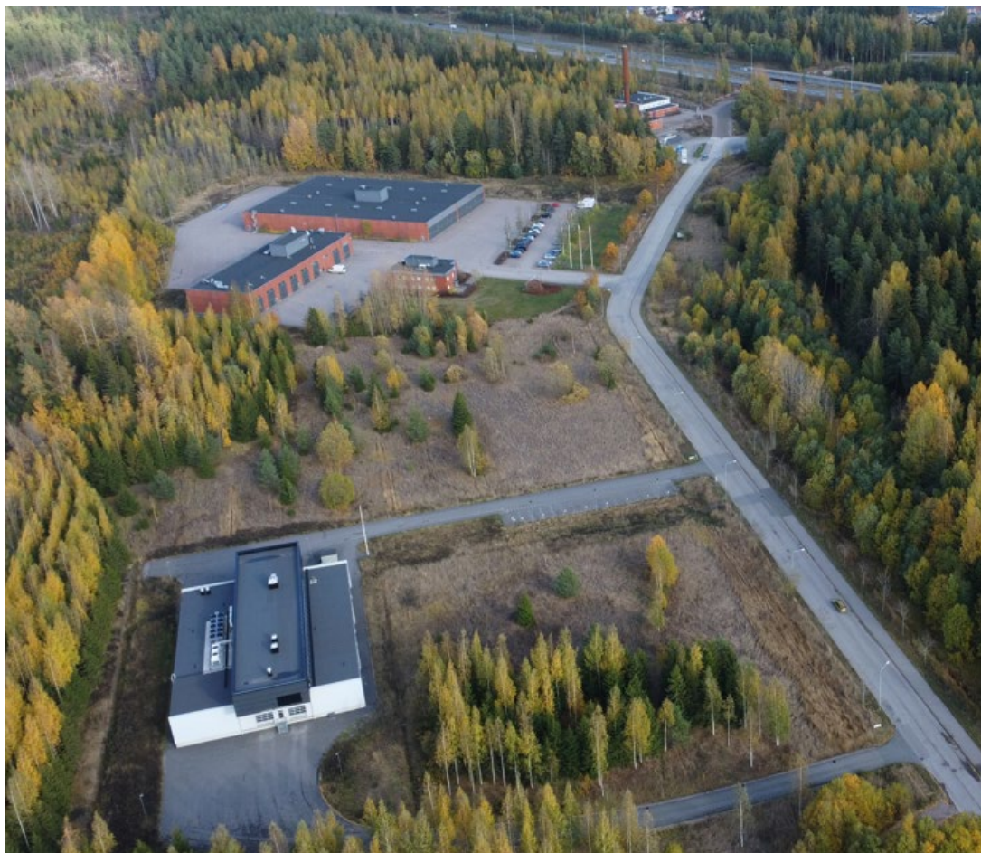
Kuva 5 Viistoilmakuvassa linja-autojen varikko taaempänä ja laitoskeittiö edessä.
