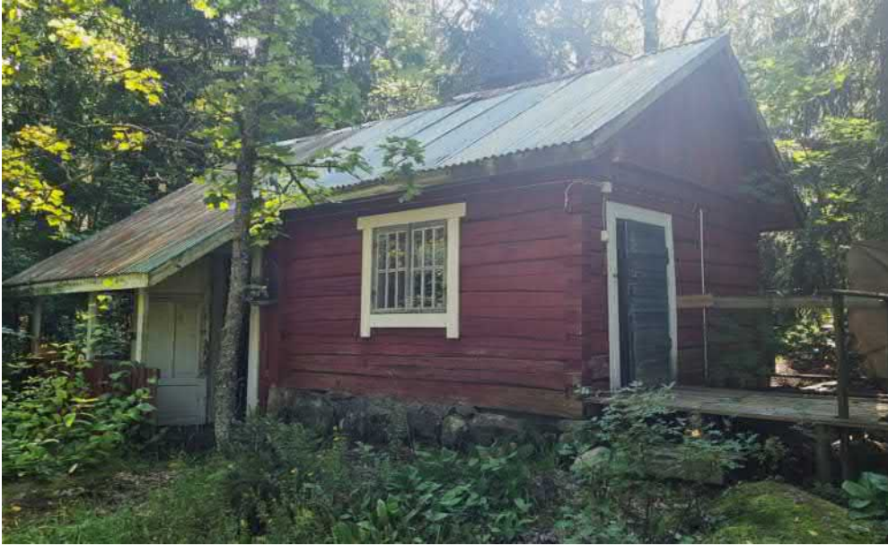
Kuva 54. Sjökullan lyhytnurkkainen hirsinen asuinrakennus/aitta. (A-Insinöörit 2024)
