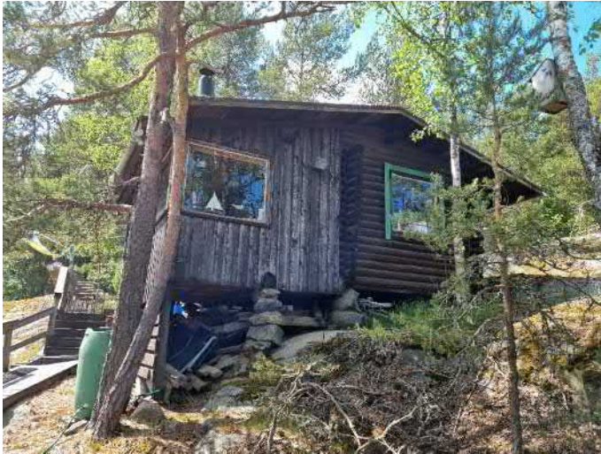
Kuva 71. Kajutan loma-asunto. (A-Insinöörit 2024)
