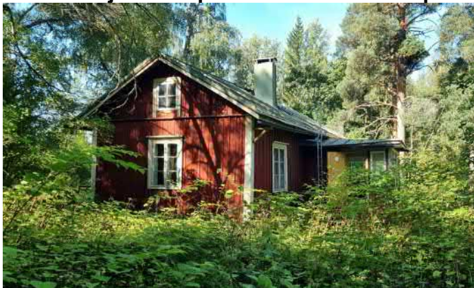
Kuva 53. Päärakennus etelän suunnasta kuvattuna. (A-Insinöörit 2024)
