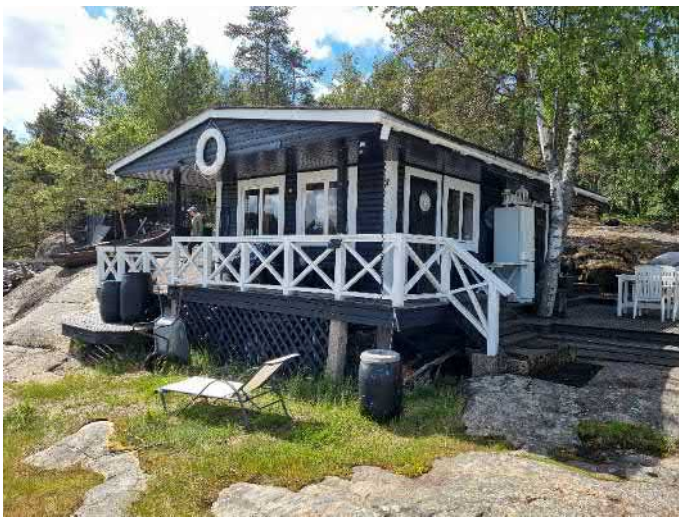
Kuva 69. Berghäll II saunamökki. (A-Insinöörit 2024)
