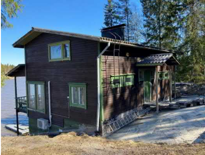
Kuva 58. Päärakennus, Merikallio. (A-Insinöörit 2023)
