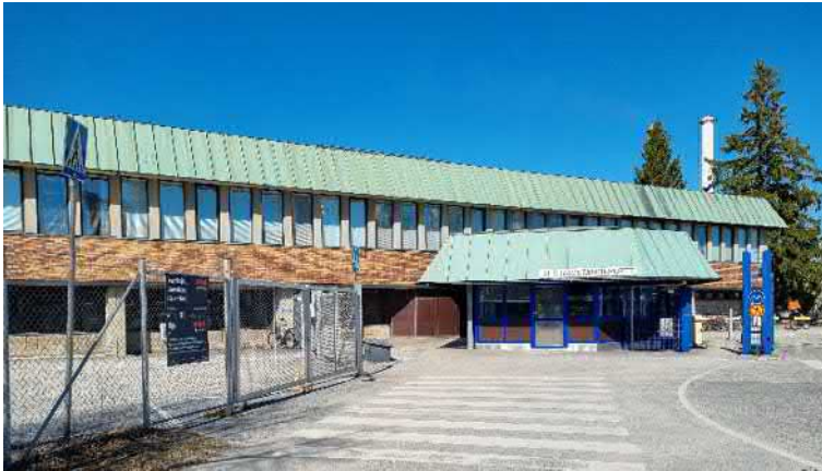
Kuva 30. Ruokalan sisäänkäynti ja eteläjulkisivua. (A-Insinöörit 2023)
