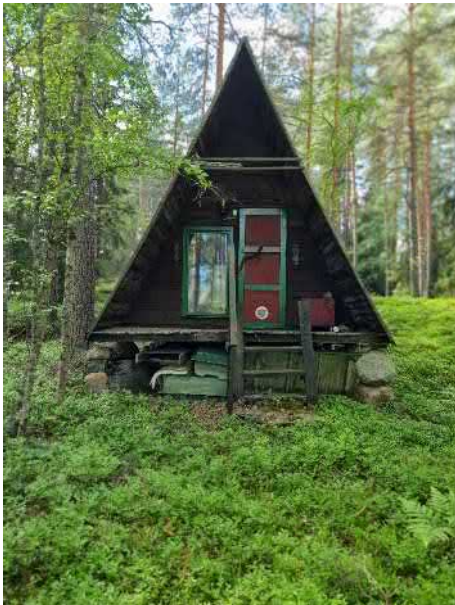
Kuva 74. Kajutan, telttamallinen makuuaitta. (A-Insinöörit 2024)
