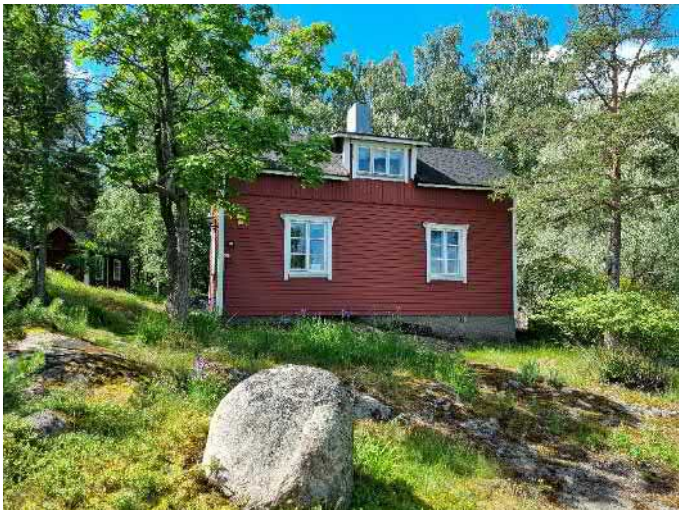
Kuva 68. Berghäll päärakennuksen julkisivu merelle. (A-Insinöörit 2024)
