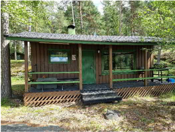
Kuva 75. Ullebo loma-asunto, julkisivu merelle länteen. (A-Insinöörit 2024)
