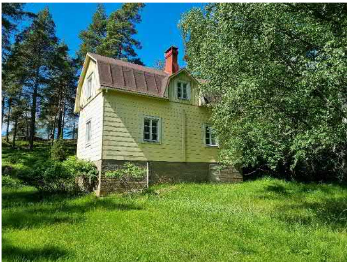
Kuva 63. Ilvardenin päärakennus. (A-Insinöörit 2024)
