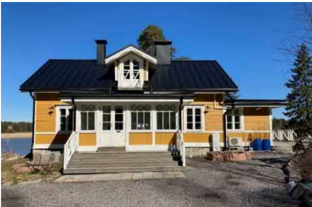
Kuva 55. Päärakennus, Prästtorp. (A-Insinöörit 2023)
