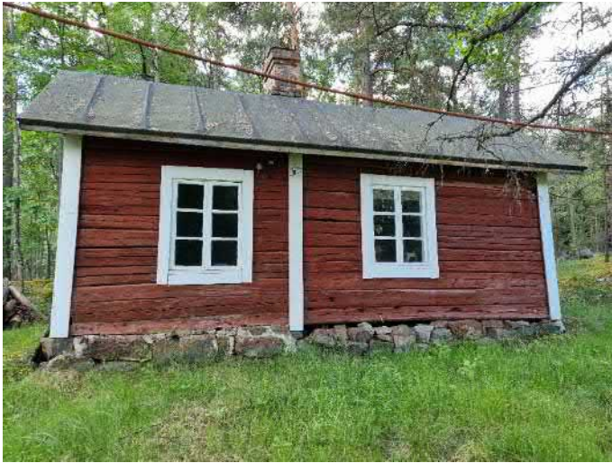
Kuva 64. Ilvarden vanha asuinrakennus. (A-Insinöörit 2024)
