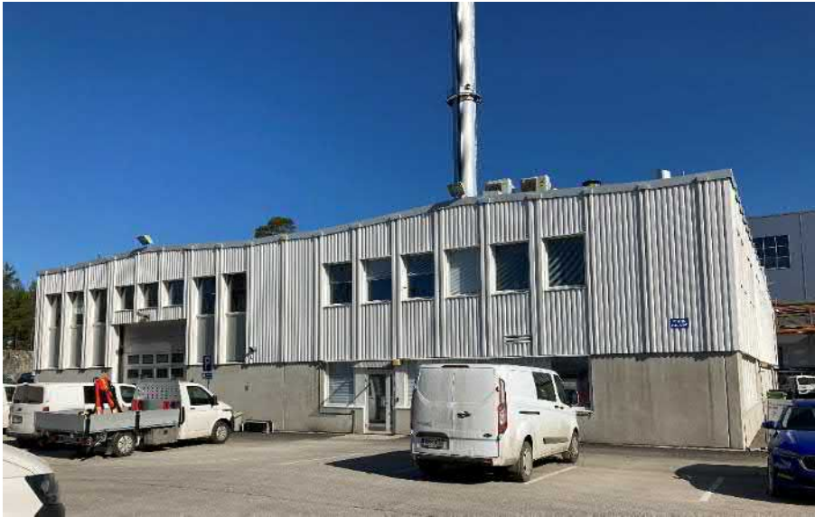
Kuva 50. Eteenin korjaamo. (A-Insinöörit 2023)
