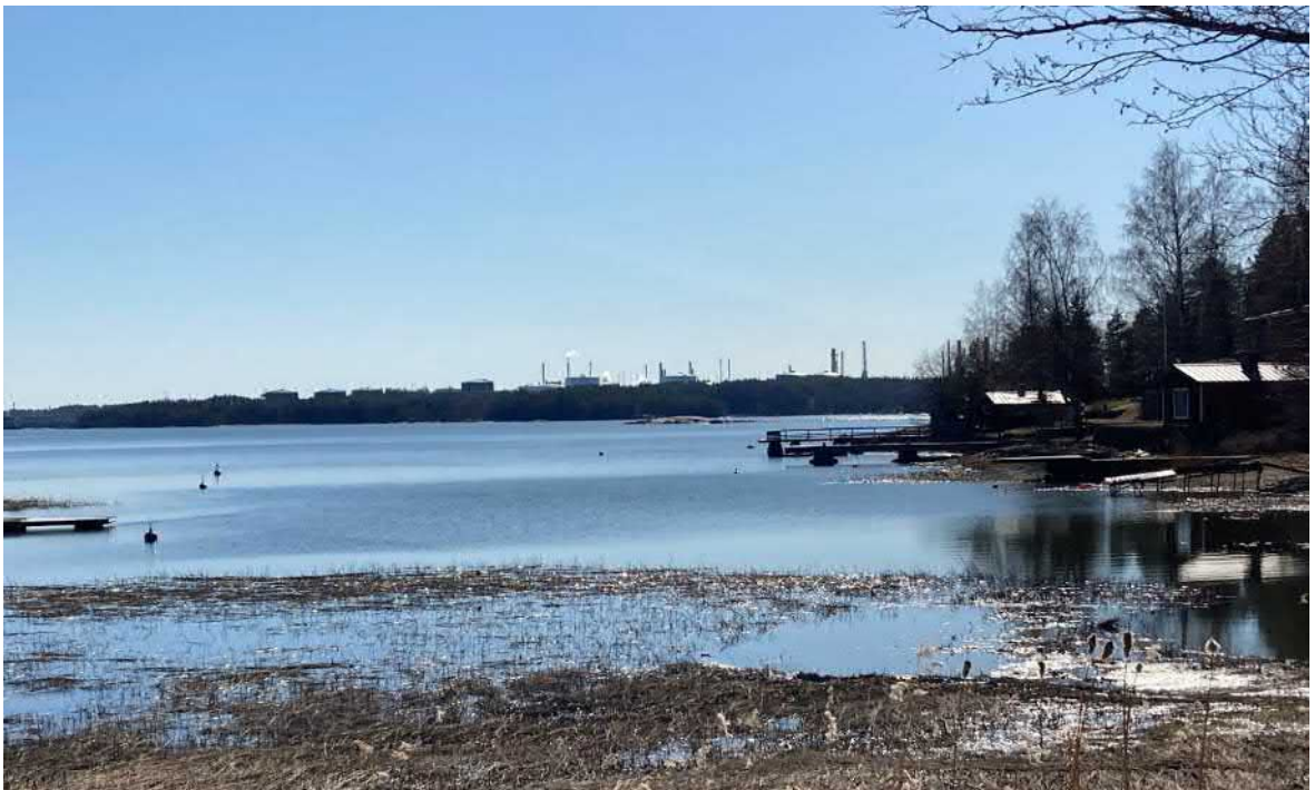
Kuva 14. Näkymä Sillvikistä Kilpilahden teollisuusalueen suuntaan, etäisyys hieman yli 2 km. Teollisuuslaitoksista näkyy korkeimpia rakenteita puuston latvusten yläpuolella ja ne hallitsevat maisemakuvaa tältä etäisyydeltä tarkasteltuna. (A-Insinöörit, 2023)
