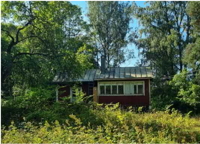
Kuva 52. Sjökullan päärakennus merelle päin. (A-Insinöörit 2024)
