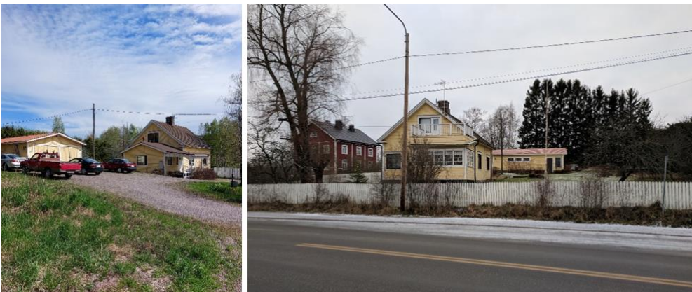
Kuva 12. Töyrytien rakennuksia Kuninkaantien varressa
