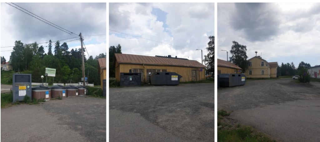
Kuva 4. Jätteenkeräyspiste ja vapaapalokunnan käytössä olevat tilat kuvattuna kiinteistön sisäpihalta päin
