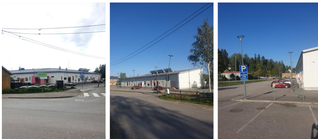
Bild 5. Daghemsbyggnad sedd från vägen och dess parkeringsområde
