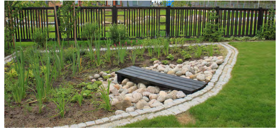
Hulevesien käsittelyä varten rakennettu istutettuja sadepuutarhoja.
