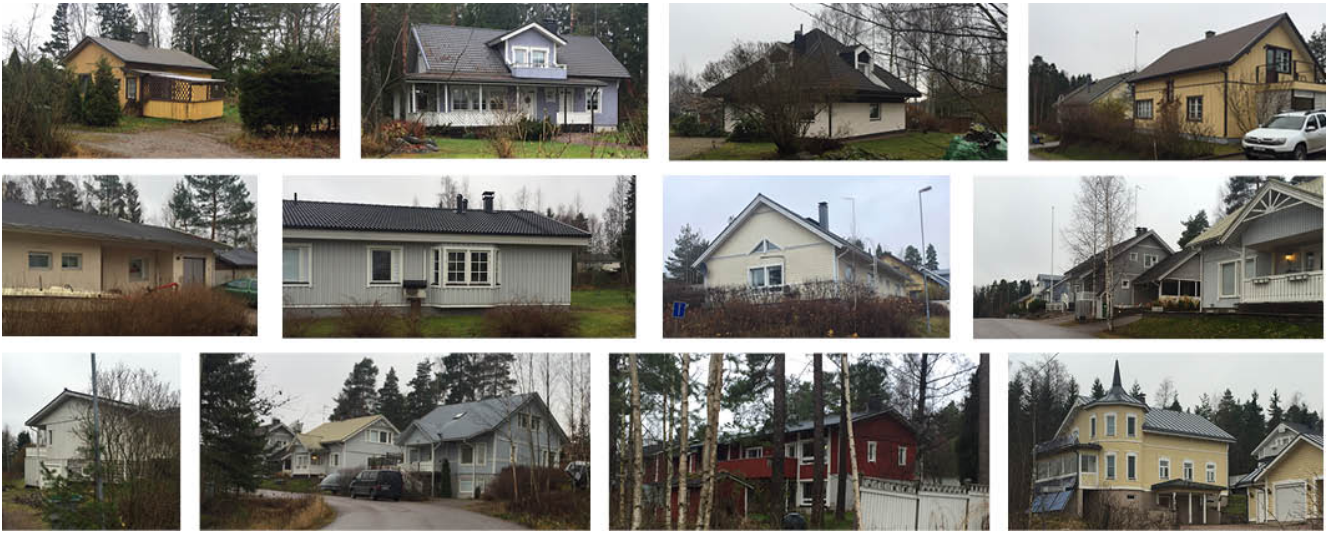
Ovan det varierande byggnadsbeståndet vid Annas väg.
