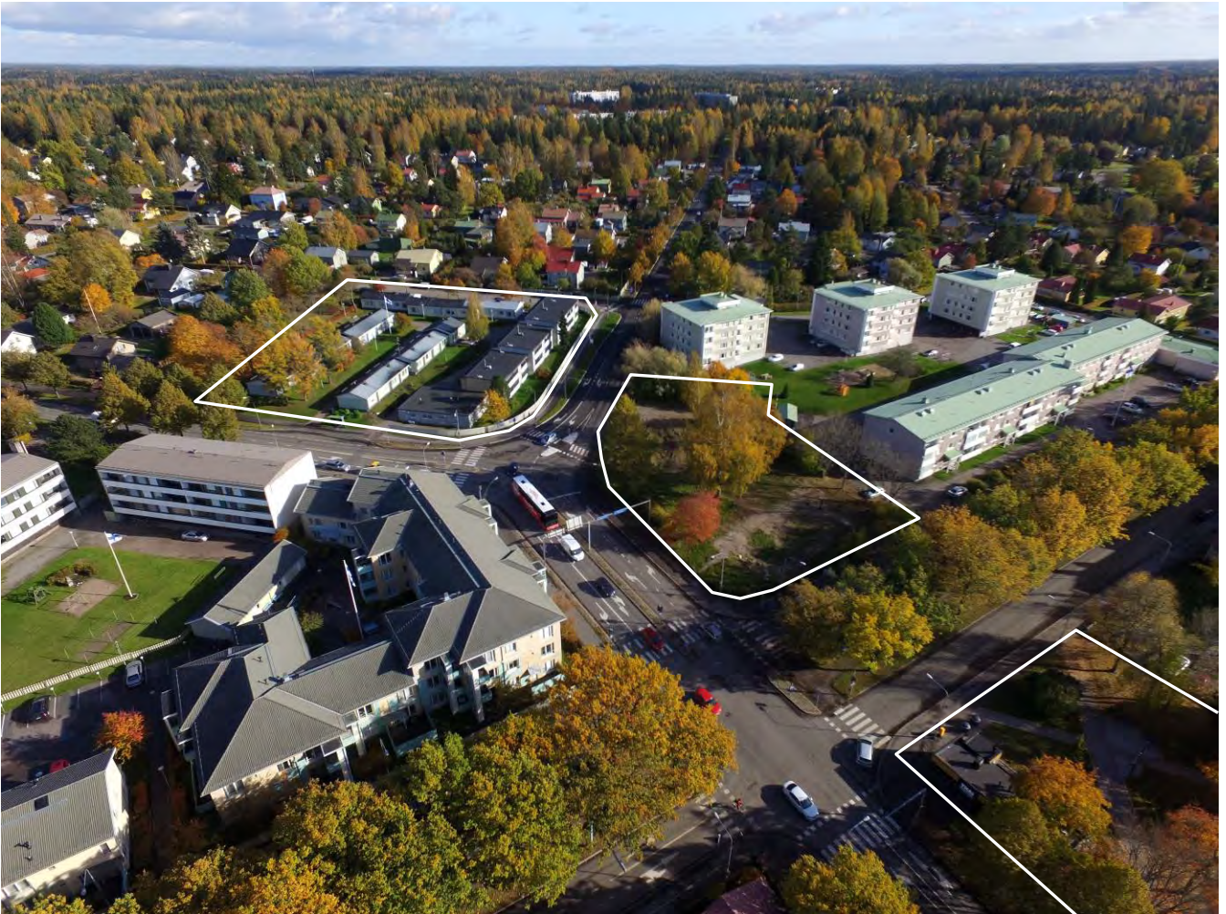
Näkymä alueelle luoteesta. Asemakaava-alue muodostuu kolmesta erillisestä palstasta, jotka on rajattu kuvaan. Ilmakuva 10.10.2018.
