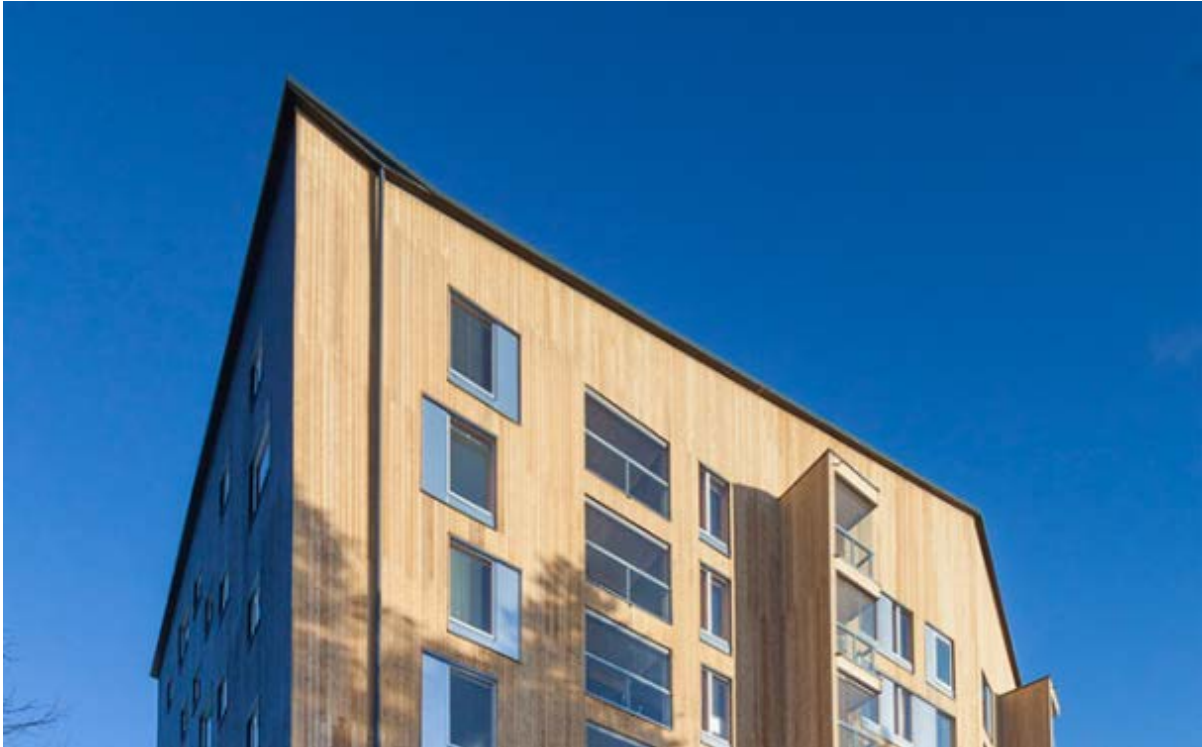
Kuva 11. Vesikaton lyhyet kantikkaat räystäät ja suora syöksytorvi. Kuva: OPEEA
