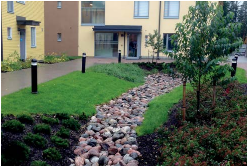
Kuva 14. Hulevesien viivytys- ja imeytysratkaisu. Kuva: Viliina Evokari, Helsingin kaupungin Hulevesiohjelma.
