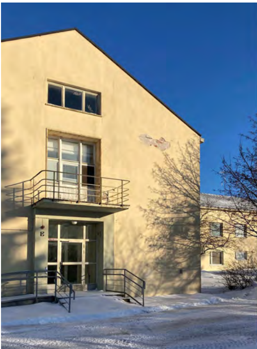
Sileä rappaus, ikkunasyvennyksen laatoitus, upotettu vedenpoistojärjestelmä ja putkikaiteet ovat kivisairaalan pelkistetyn arkkitehtuurin piirteitä, jotka tulee säilyttää korjauksessa.
