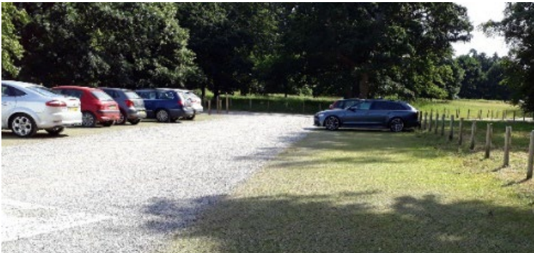
5Kuvat: Ajoreitin ja autopaikan voi rakentaa kiviaineksella tai tukiverkoilla vahvistettuna nurmena, leveäsaumaisena kiveyksenä tai nurmisaumaisin laatoin. Kantava kasvualusta sopii huleveden imeyttämiseen ja viivyttämiseen ja se mahdollistaa rehevän kasvillisuuden ja puiden menestymisen pysäköintipaikan vieressä.
