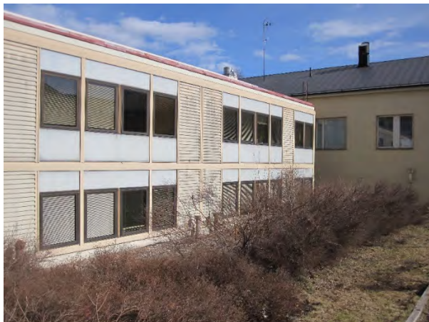
Fasaderna på tillbyggnaden av ämbetshuset från 1977 avviker från den övriga helheten. Fasaderna har konstruktivistiska drag som lyfter fram strukturen. Mellan fönstren finns korrugerad plåt, och ovanför och under fönstren finns plastpaneler.
