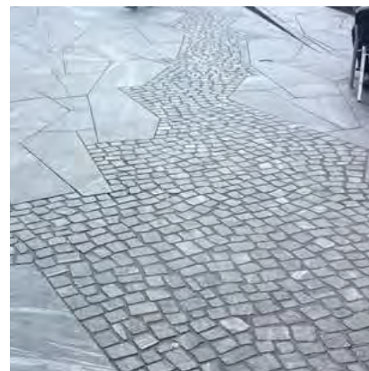
Alternativ 3: Specialplatta, mosaikfigur Variation med ytbehandling eller med att kombinera vanliga stenar med storgatstenar eller nubbsstenar.
