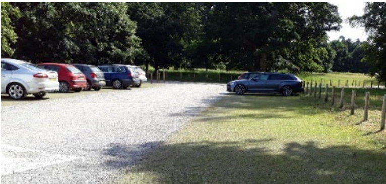
5Bilder: Körbanan och bilplatsen kan byggas med stenmaterial som förstärks med gräsmatta, bredfogad stensättning eller med plattor fogade med gräsmatta. Ett bärande växtunderlag lämpar sig för att infiltrera och fördröja dagvatten och gör det möjligt för frodig vegetation och träd att växa väl bredvid parkeringsplatsen.
