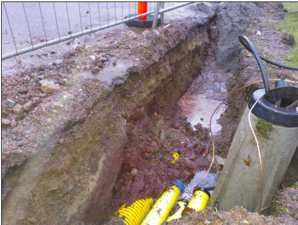
Kuva 2. Kaivannossa näkyvissä punertavaa täyttökerrosta.
