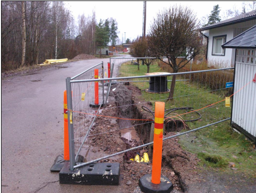
Kuva 1. Yleiskuva kohteesta Tolkkistentielle päin. Kaapelikaivanto sijaitsee rivitalokiinteistön rajan tuntumassa.
