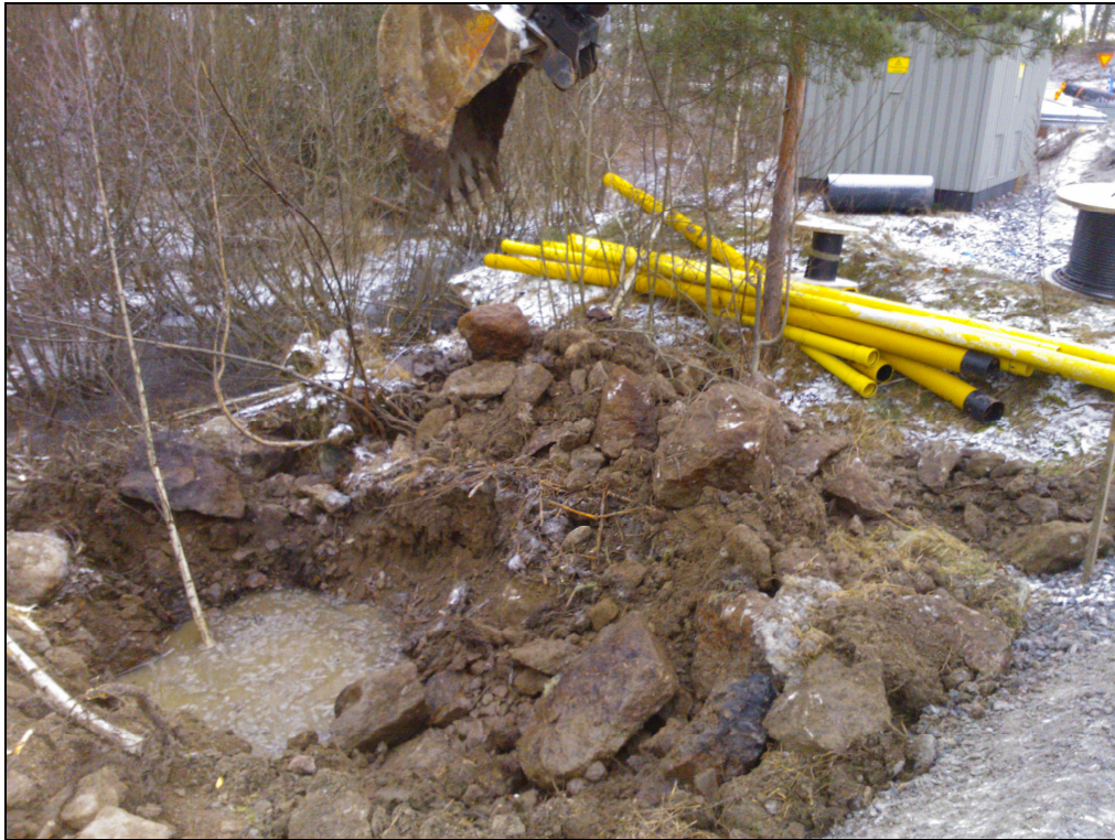
Kuva 9. Koekuopasta KK7 ei todettu jätetäyttöä eikä kohonneita metallipitoisuuksia.
