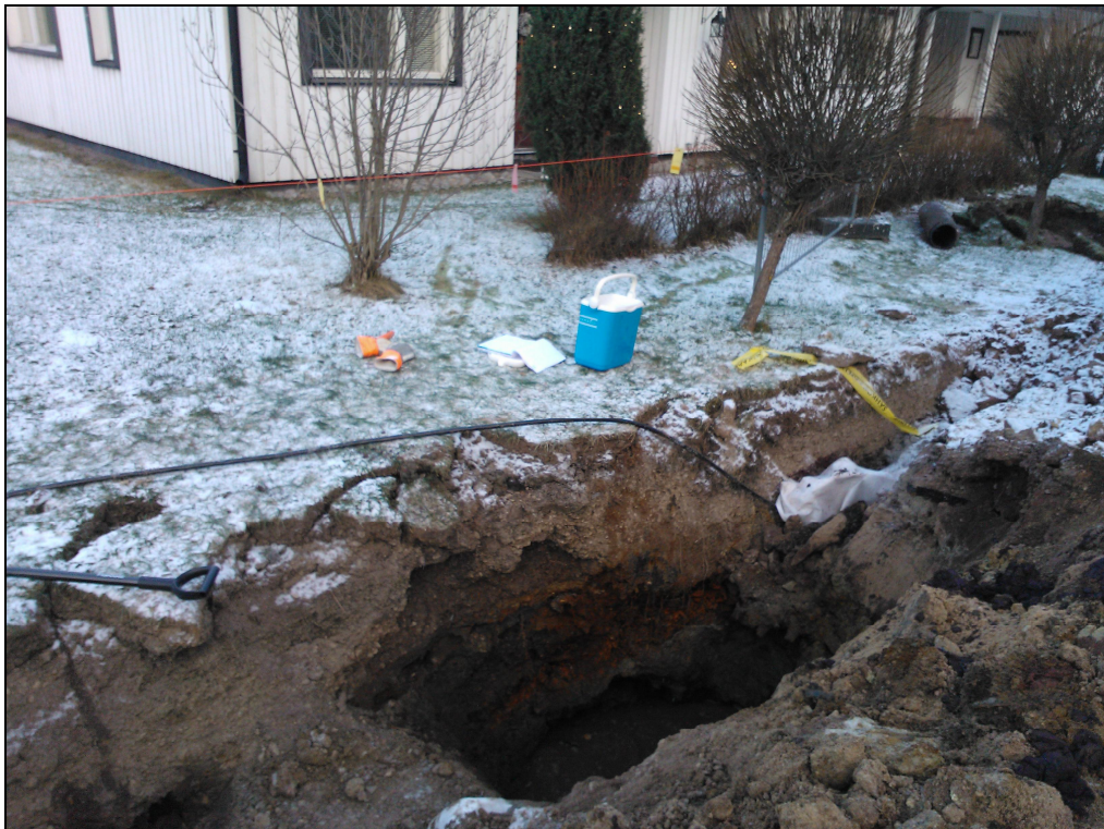
Kuva 6. Koekuoppa KK5 tehty kaapelikaivantoon.
