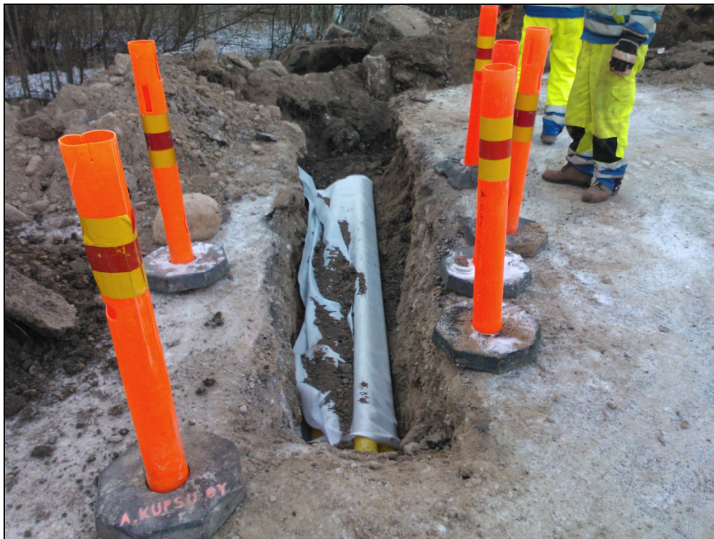
Kuva 11. Tutkimusajankohtana 9.12.2013 tekeillä ollut uusi kaapelikaivanto Kissanalmentien poikki. Kuvassa näkyvissä näytteen K1 näytealue.
