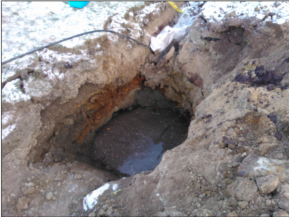
Kuva 5. Koekuoppa KK4 tehty kaapelikaivantoon.
