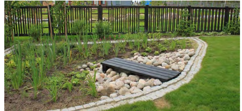
Kuva 15. Hulevesien käsittelyä varten rakennettu istutettu sadeputarha.
