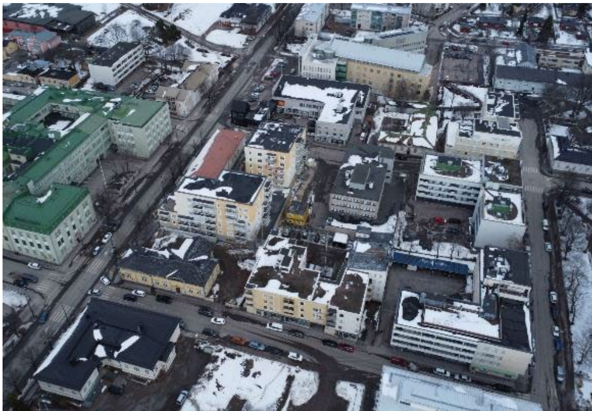
Kuva 4. Ilmakuva lännestä 18.3.2023. Asemakaava-alue kuvan keskivaiheilla yläoikealla. Kuvasta näkyy hyvin suunnittelualueen suhde lähiympäristöönsä. Suunnittelualueen länsipuolella ns. Marski Rooftop -kiinteistö (Linnankoskenkatu 45 - 47). Vasemmalla Mannerheiminkadun varrella kookas ns. WSOY:n kortteli vihreissä sävyissä. Keskellä vasemmalla kahden vuonna 2023 valmistuneen asuinkerrostalon kokonaisuus (Arkworks Arkkitehdit Oy).
