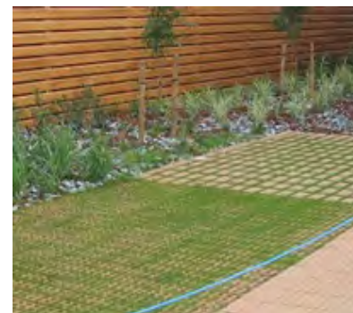
Bild 18. Stenbeläggning med gräs på parkeringsplats. Vattnet som rinner längs ytan leds till växterna vid kanten.
