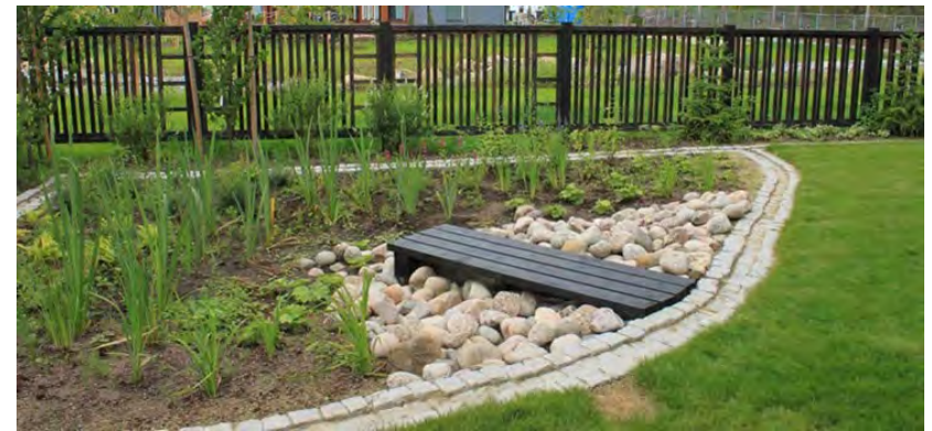
Bild 15. En planterad regnträdgård byggd för dagvattenhantering.
