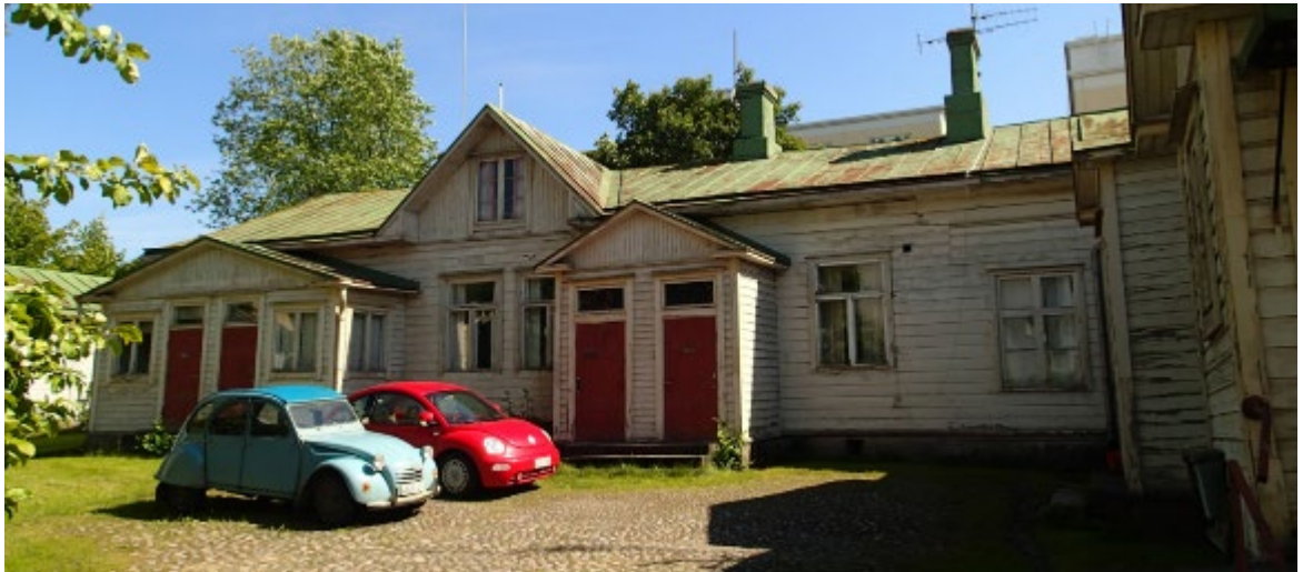
Bild 1. Vy från porten mot gården. En skymt av ekonomibygnaden syns i bildens vänstra kant. I förgrunden kan man mycket väl se gårdens stenläggning, som vittnar om den industriella perioden. Källa: Byggnadsinventering av empirecentrum. Bild från 4.7.2014.
