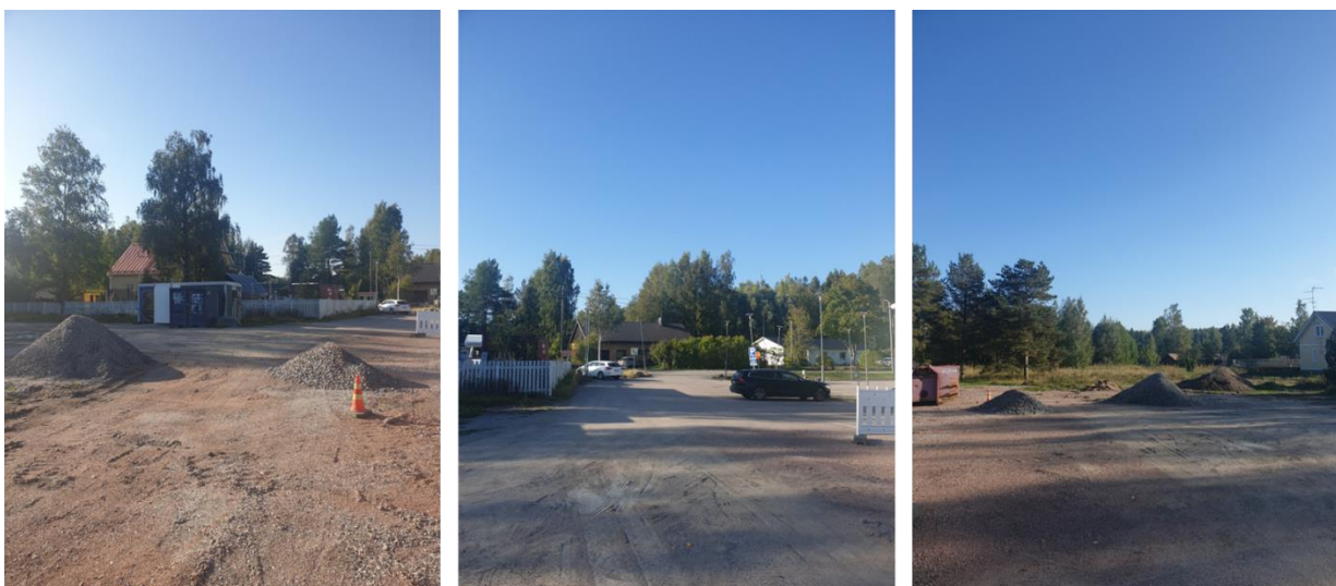
Kuva 8. Kaupunkiomisteinen alue Rengastiellä, josta purettu palveluasumisen rakennuksia
