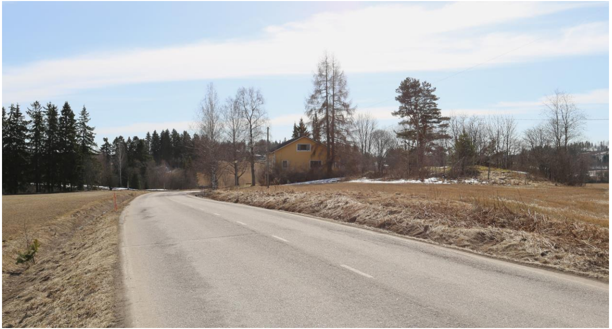
Kuva 3-4. Nykytilamaisemaa Monninkylän eteläpuolella reittivaihtoehdon VE 2 ja Kaarenkyläntien risteyshaudan pohjoispuolelta kuvattuna kohti etelää.
