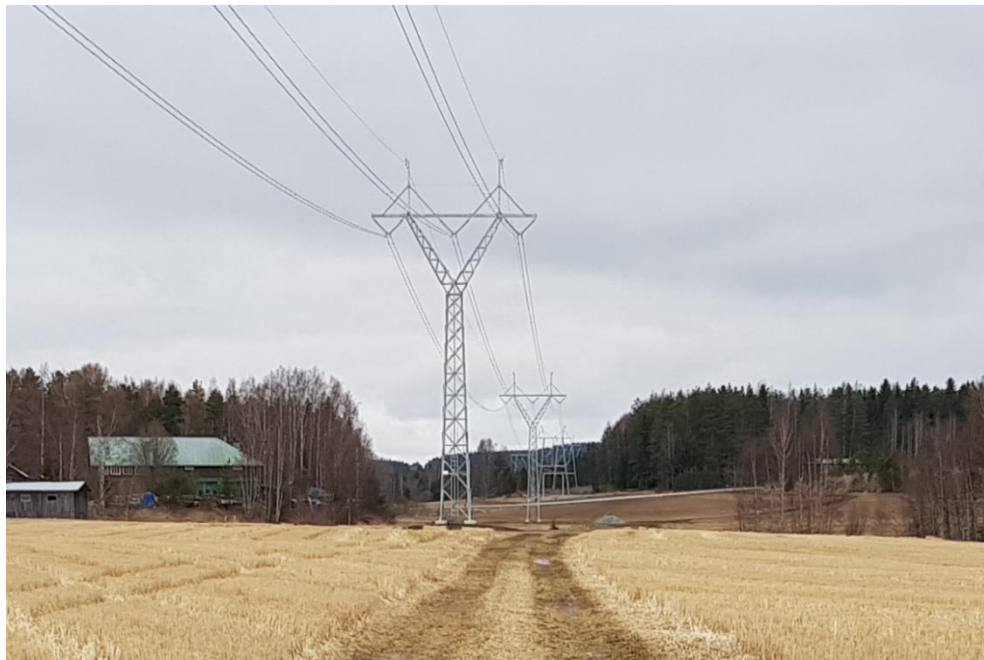
Kuva 1-5. Havainnekuva 1Y-tyyppisestä pylväsrakenteesta peltoaukealla.
